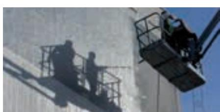
Décapant spécial pour les façades en béton, les pierres et les enduits non peints. Permet de nettoyer et de désinfecter en une seule opération et empêche les salissures de se redéposer tout en étant particulièrement efficace pour éliminer les suies, fumées, hydrocarbures, oxydes de carbone, le film routier et les saletés laissées par la pluie et la pollution.
